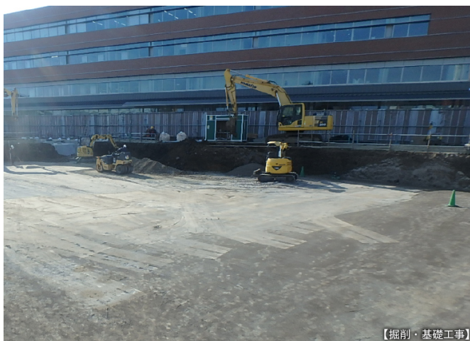
掘削・基礎工事
