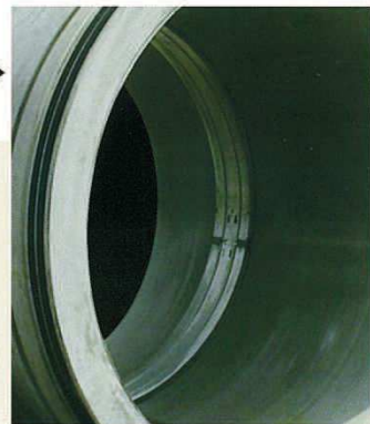
誘導目地に沿って取り付けしたマグマロック
