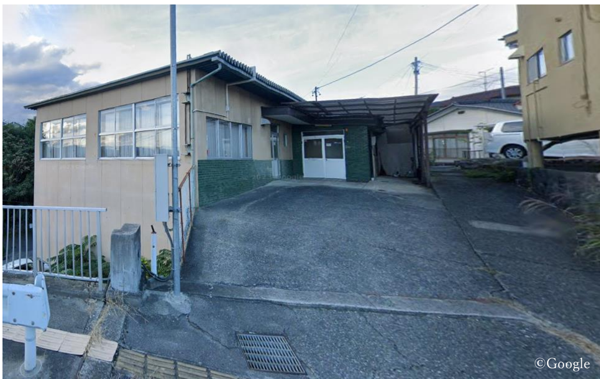
図 2 - 1 建物の外観（国道 153 号線から施設のデッキプレート及び 2 階部分）
