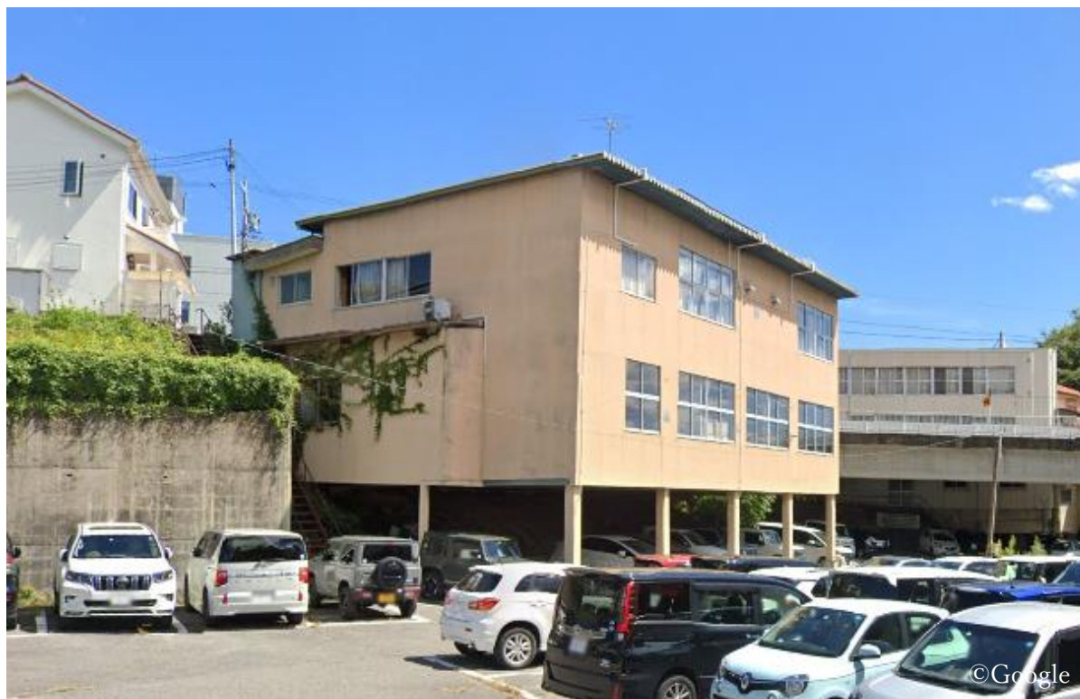
図2-3 建物の外観（職員駐車場から施設の全体）
