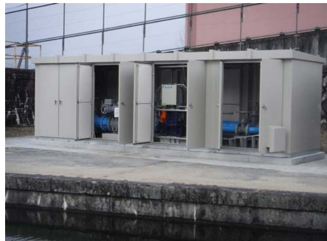
砂払浄水場 マイクロ水力発電施設(場所貸し)
