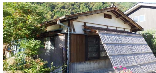
中橋市営住宅
