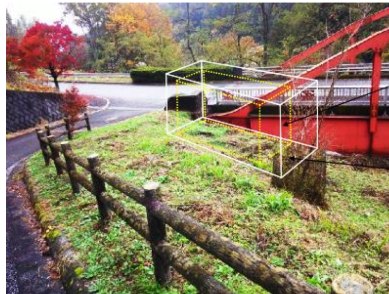
作業ヤード写真 (路上→土手)
