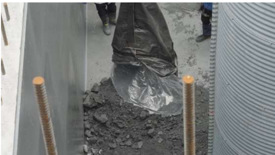
ケーソン内部での土嚢開封状況 2
