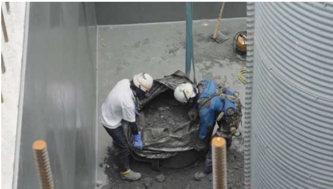
ケーソン内部での土嚢開封状況 1
