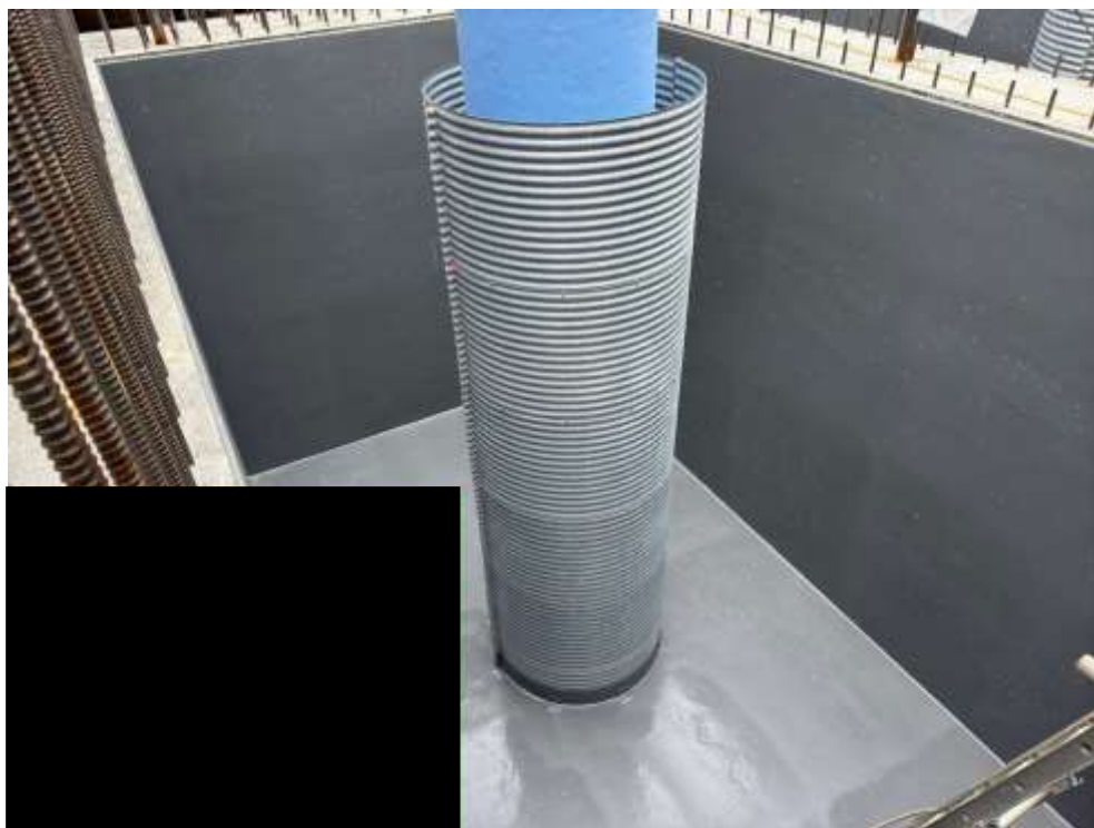
ケーソン基礎（P1）施工写真（漏出防止措置）
