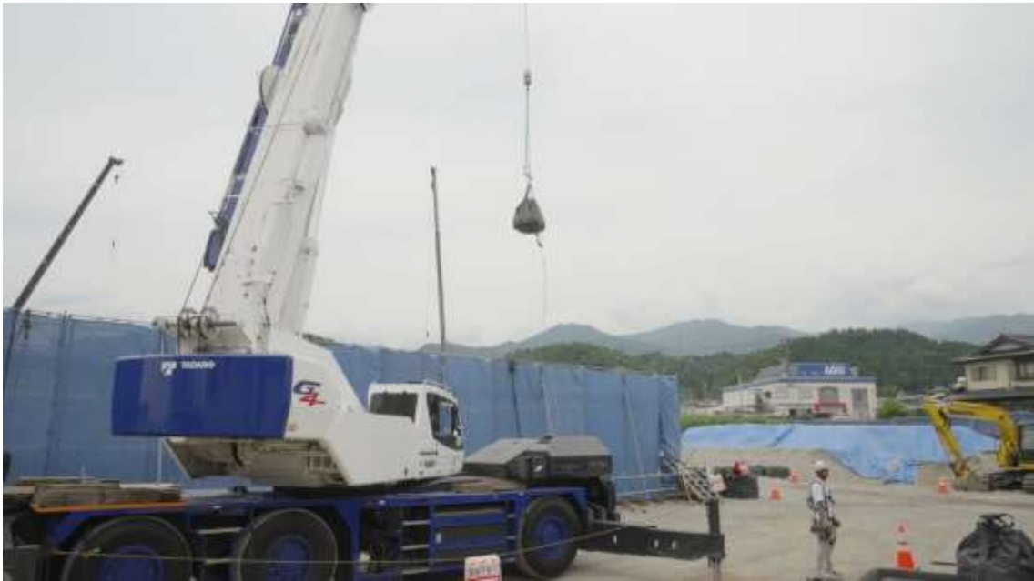
クレーンによるケーソンへの投入状況 1
