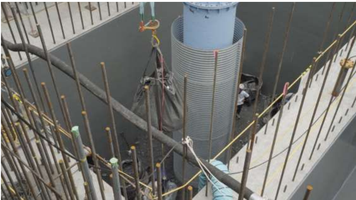
クレーンによるケーソンへの投入状況 2
