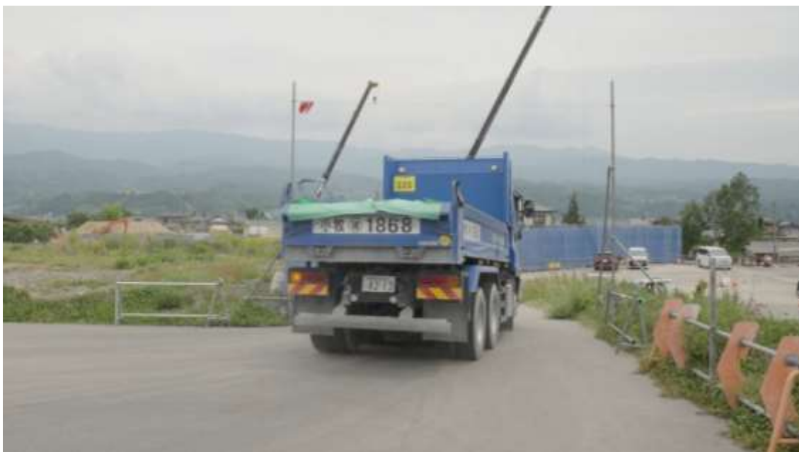
工事ヤードへの搬入状況
