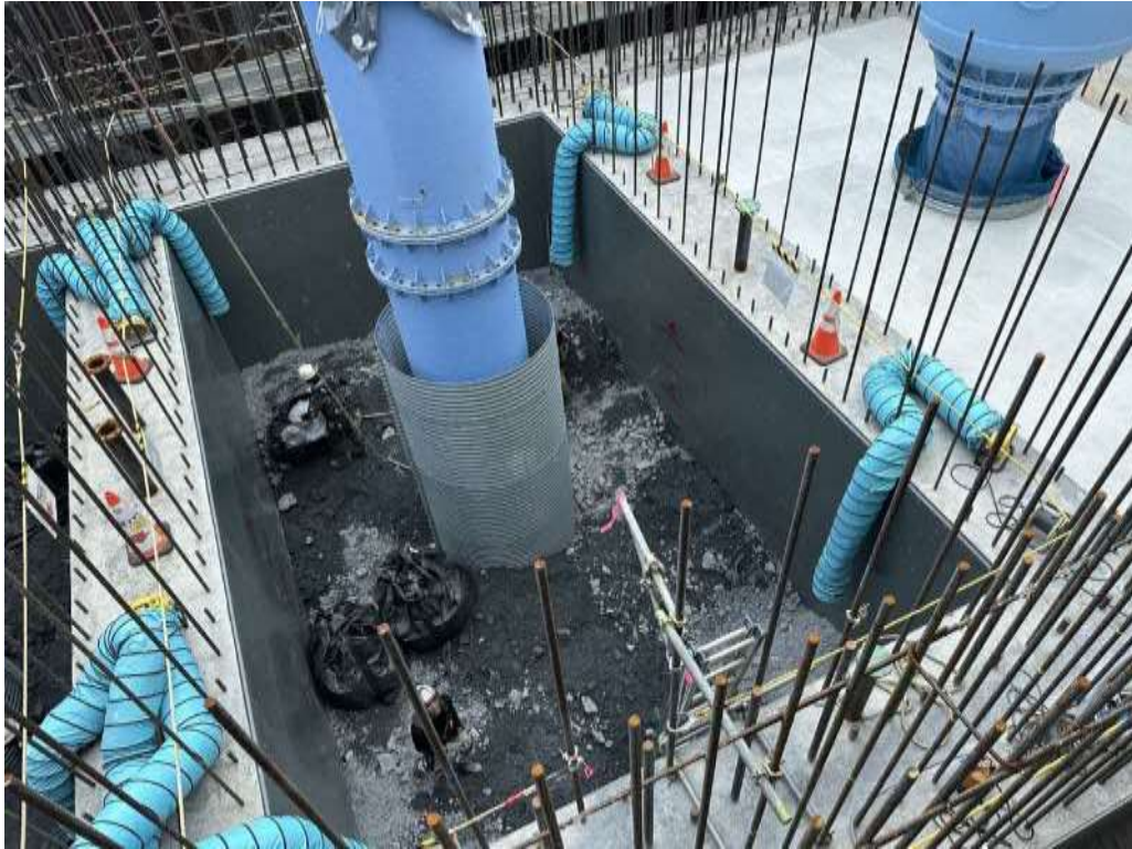
ケーソン基礎 (P1) 施工写真
