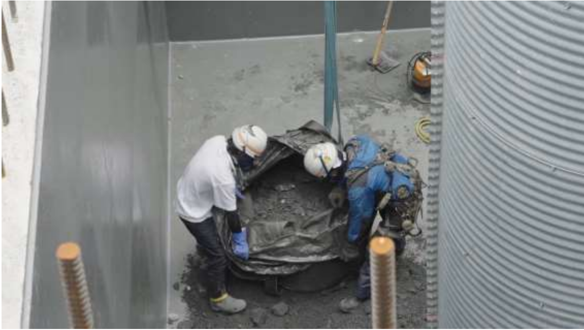
ケーソン内部での土嚢開封状況 1
