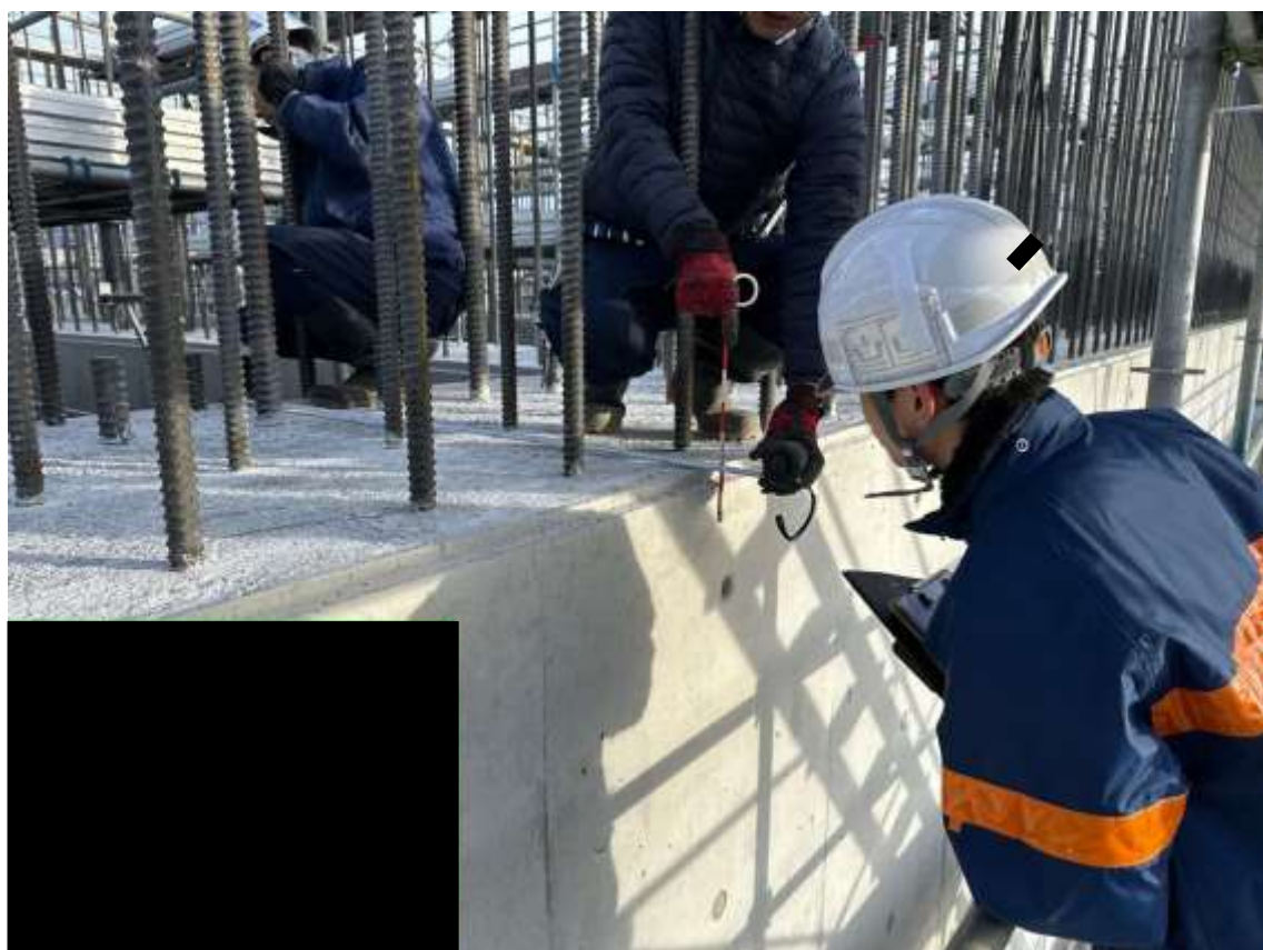
ケーソン基礎 (P1) 施工写真
