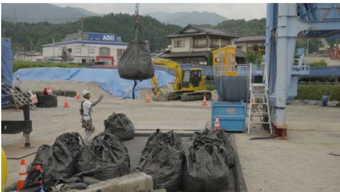
取卸し場への仮置き状況
