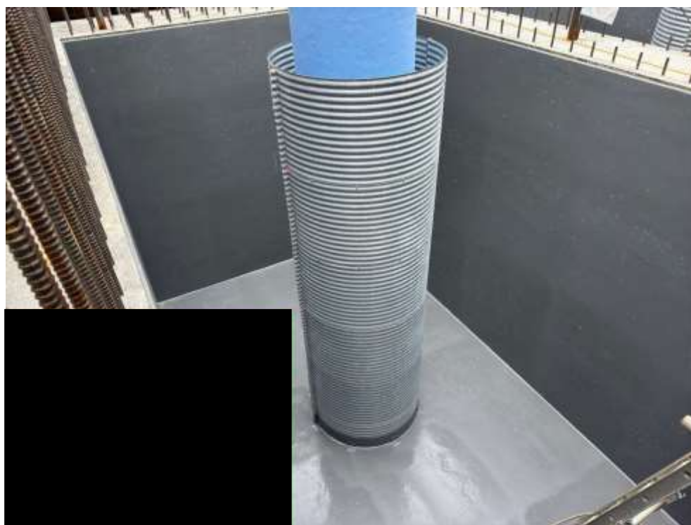
ケーソン基礎 (P1) 施工写真 (漏出防止措置)
