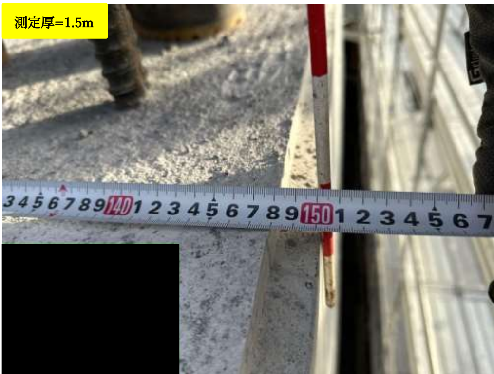
ケーソン基礎 (P1) 施工写真
