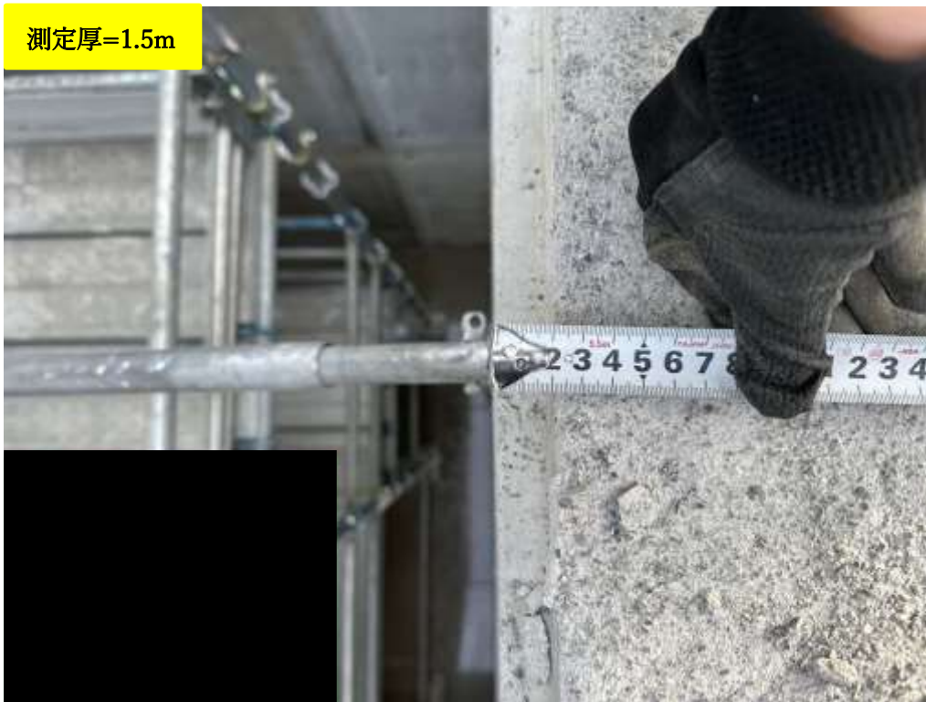
ケーソン基礎 (P1) 施工写真
