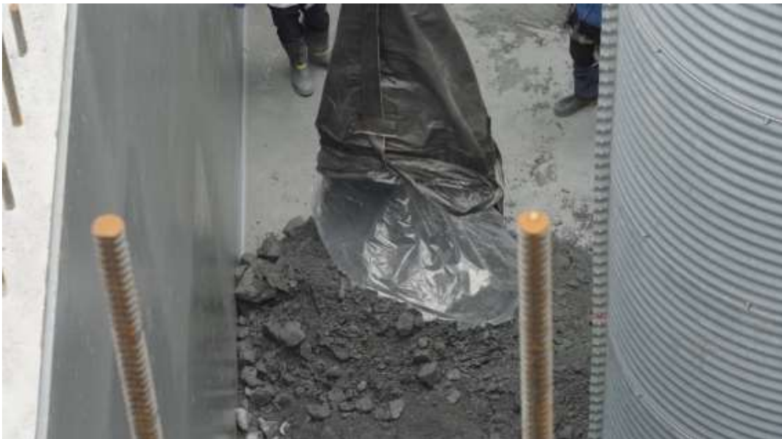
ケーソン内部での土嚢開封状況 2
