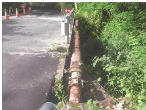
工事前上流側（亜鉛メッキ鋼管 φ150mm）
