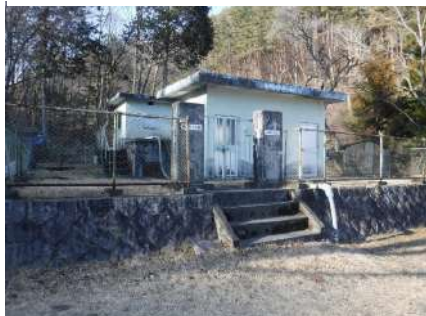
旧上郷第1配水池（更新前） （容量62.5m 3 、1池構造）
