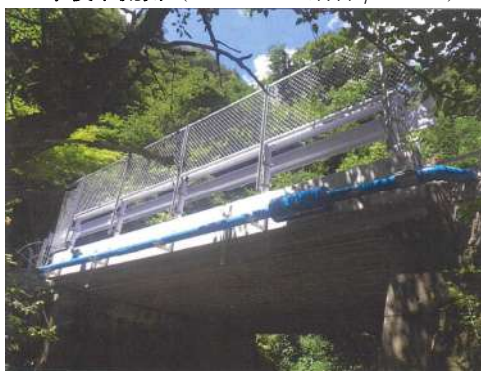
工事後下流側（ステンレス鋼管 φ75mm）
