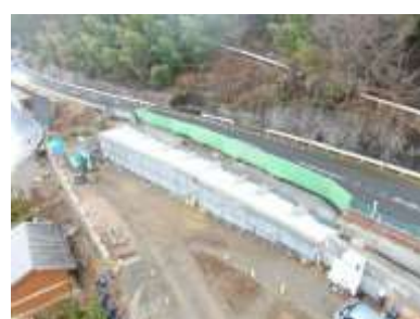
軽量盛土工・擁壁等拡幅工事を 実施
