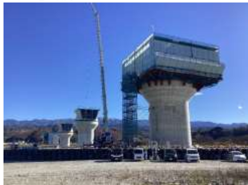
飯田市側の上部工工事を実施
