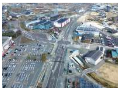
新設交差点供用（イオン前）
