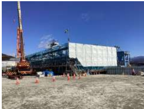
土曽川橋りょう（P2）の橋脚基礎工事を実施
