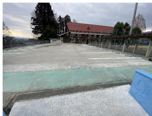
R6 駐車場として整備した追手町小プール跡地
