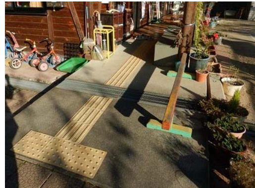
段差なし（スロープ設置）
