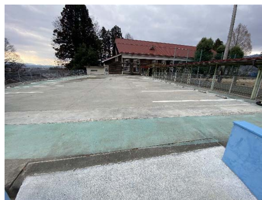
R6 駐車場として整備した追手町小プールの状況
