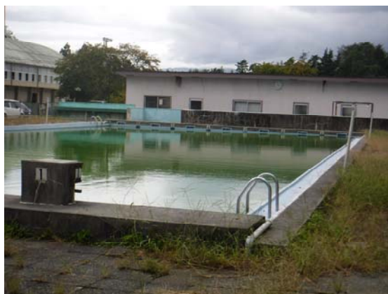
H30 竜東中プールの状況
