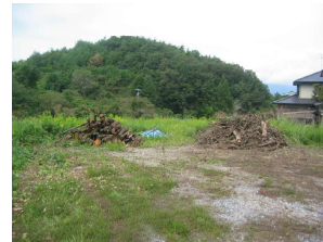
撤去した支障木
