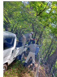
野生鳥獣対策防護柵補修作業
