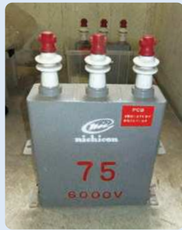
電力用コンデンサー
