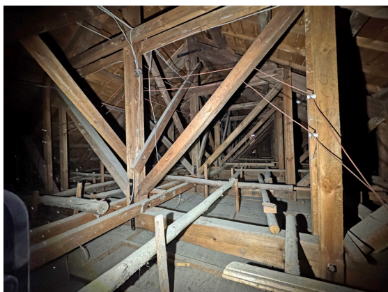
図6 小屋裏の架構
