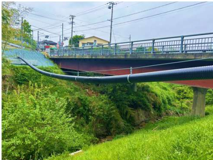
座光寺 宮崎橋 \phi 150\text{mm} (更新後)
