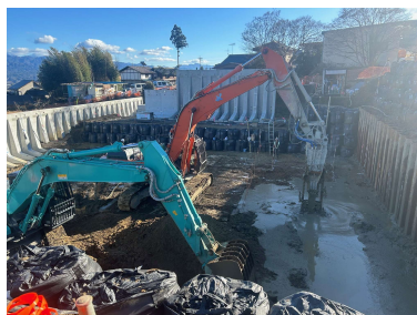
地盤改良施工
