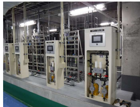
注入ポンプ設置状況
