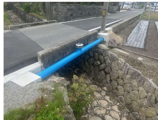
工事後 (ステンレス鋼管 \phi 75mm)
