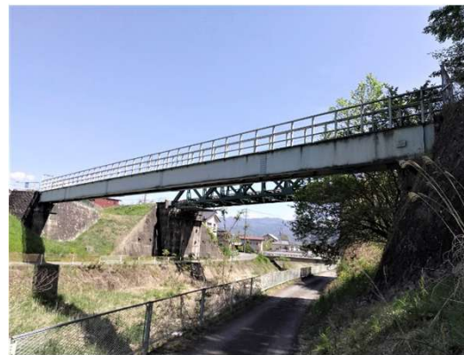
野底川水管橋 (更新前) \phi 400\text{mm}
