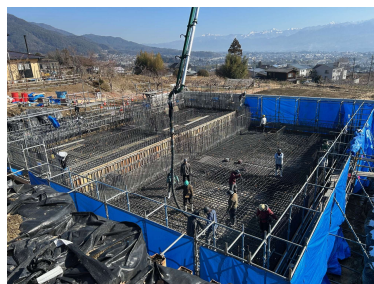
コンクリート打設
