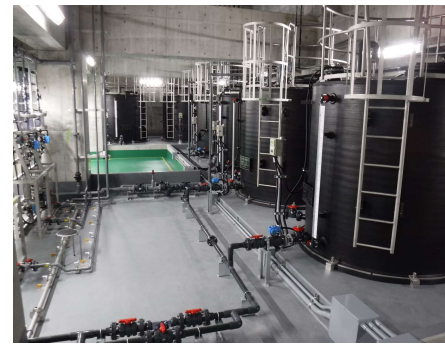
貯水槽設置状況
