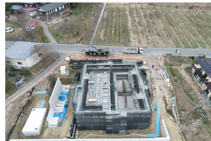
工事状況（令和8年3月）
