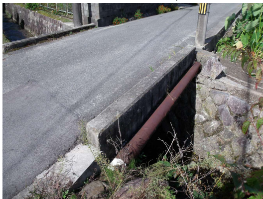
工事前 (亜鉛メッキ鋼管 \phi 100mm)
