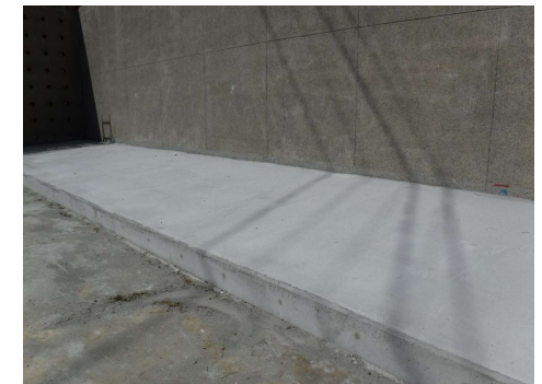
第2貯水池耐震補強工完了
