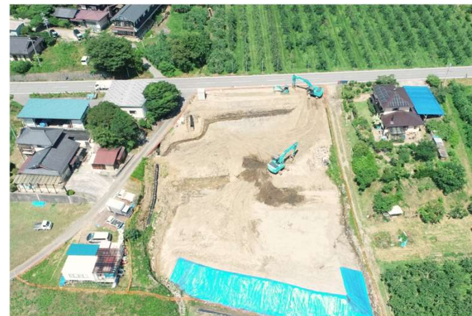
工事状況（令和7年6月）
