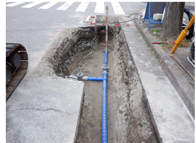
高羽町 (HPPE型) \phi 100mm
