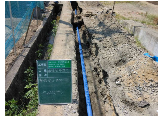
高羽町 (HPPE型) \phi 100mm
