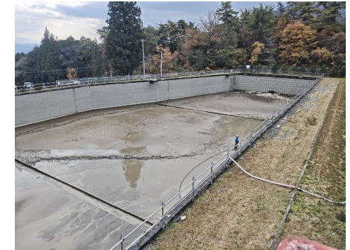
第2貯水池水抜き清掃作業
