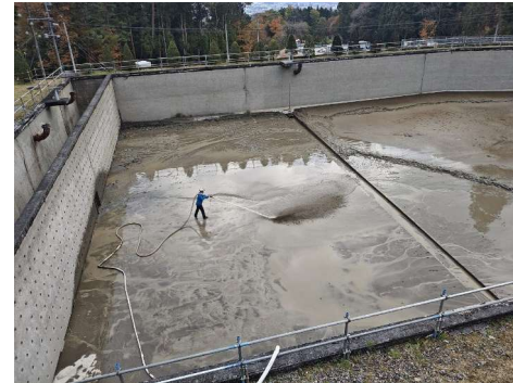
第2貯水池水抜き清掃作業
