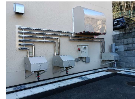
薬品受入れ口設置状況
