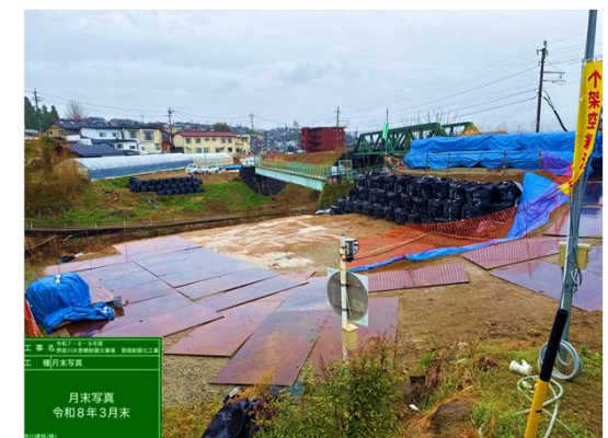
工事状況 (R8年3月)
