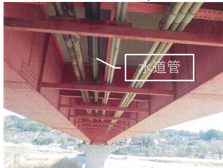
アリッド外装のリフレッシュ管 \phi 150\text{mm}
