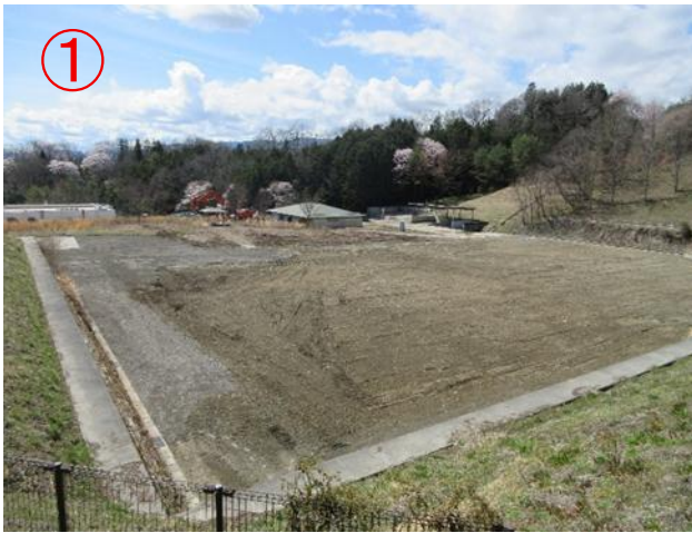
(3) 解体完了 (3月末)
