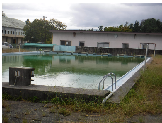
H30 竜東中プールの状況
