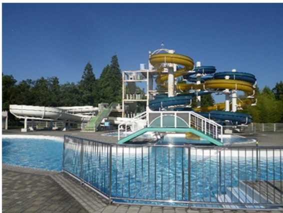
■ 飯田運動公園プールウォータースライダー
