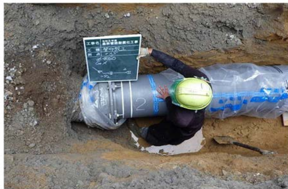
基幹管路耐震工事（DIP.GX型φ400mm）
