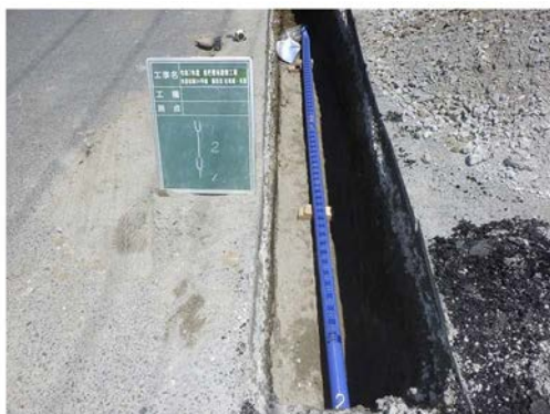
老朽管布設替工事（HPPEφ75mm）
