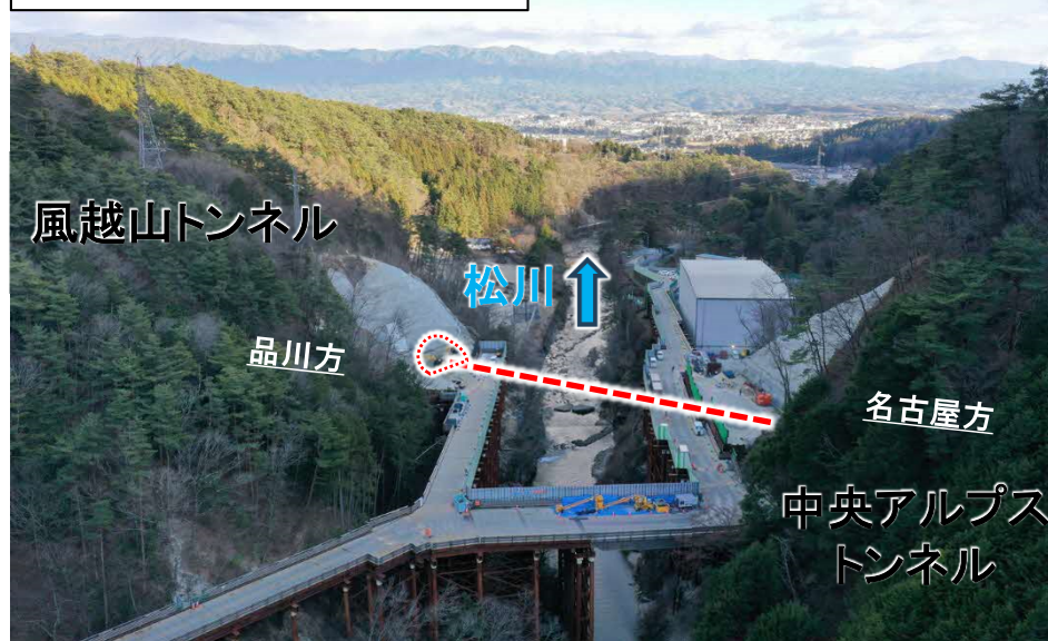
①本線トンネル坑口付近(松川)
