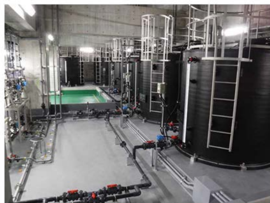
薬品貯蔵槽設置状況
