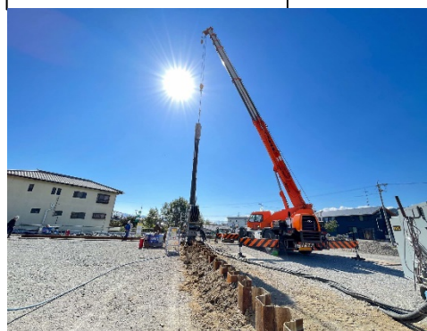
① 鋼矢板打込み
