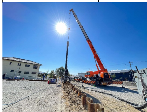
① 鋼矢板打込み
