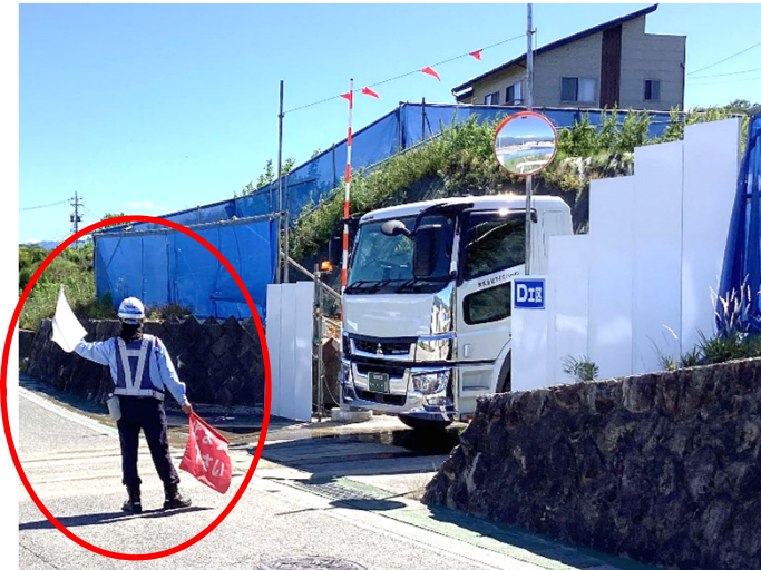
交通誘導員配置 (工事用車両出入口に配置)
