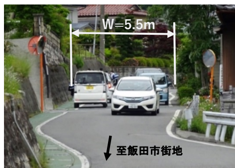
普通車のすれ違いが困難な状況
