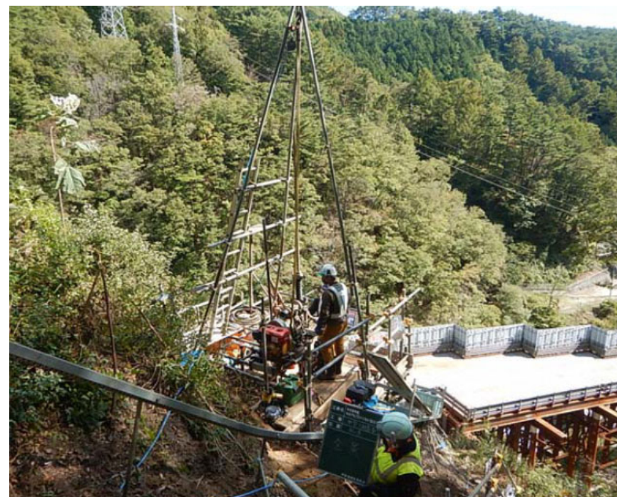
追加の地質調査の状況
