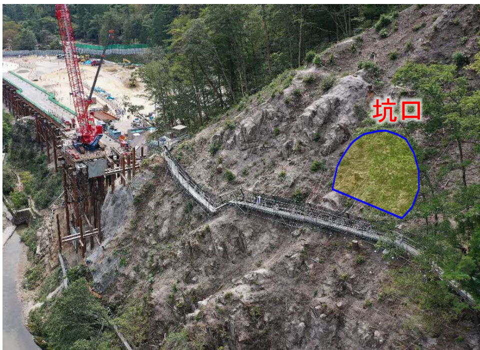
伐採時の坑口部の状況
