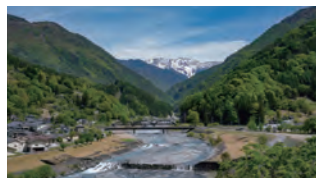
小波橋と南アルプス赤石岳(長野県大鹿村)
