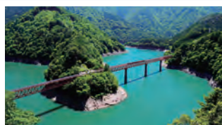
奥大井湖上駅(静岡県川根本町)
