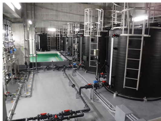
薬品貯蔵槽設置状況
