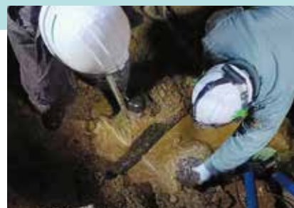
破損した水道管の修理工事
