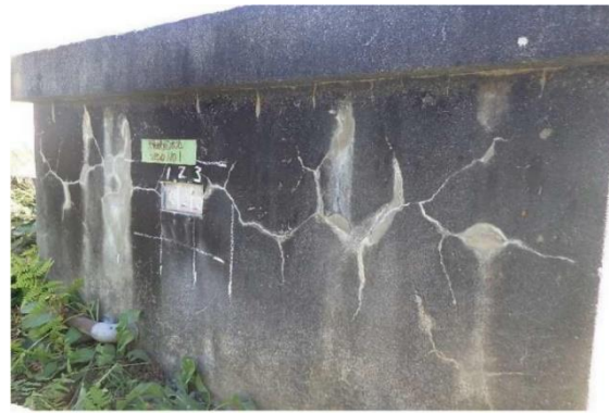
天竜峡配水池
