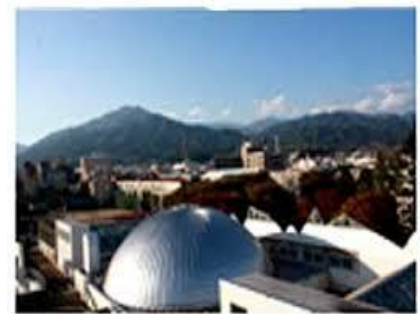
<当館屋上のドーム>
