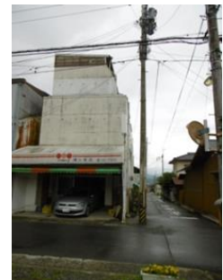
▲ 改修前の空きビル外観
