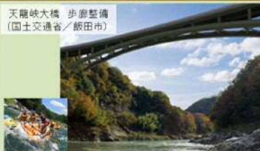
天龍峡大橋 歩廊整備 (国土交通省／飯田市)
