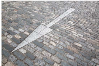
舗装材張替えによるサイン
